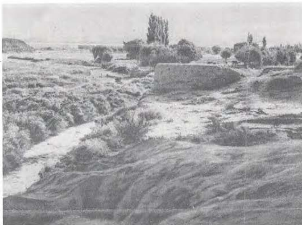
Ruinas del Fuerte a orillas del Río Diamante
