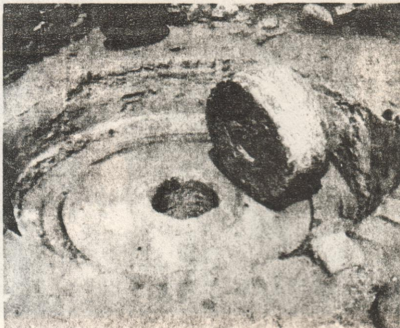
Fig. 12. Solera y rueda del Molino Hidráulico.
